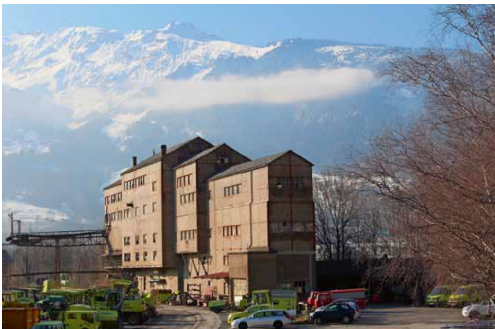
In der Anlage Malerva wurde das Erz zerkleinert, sortiert und in Bahnwagen verladen.
