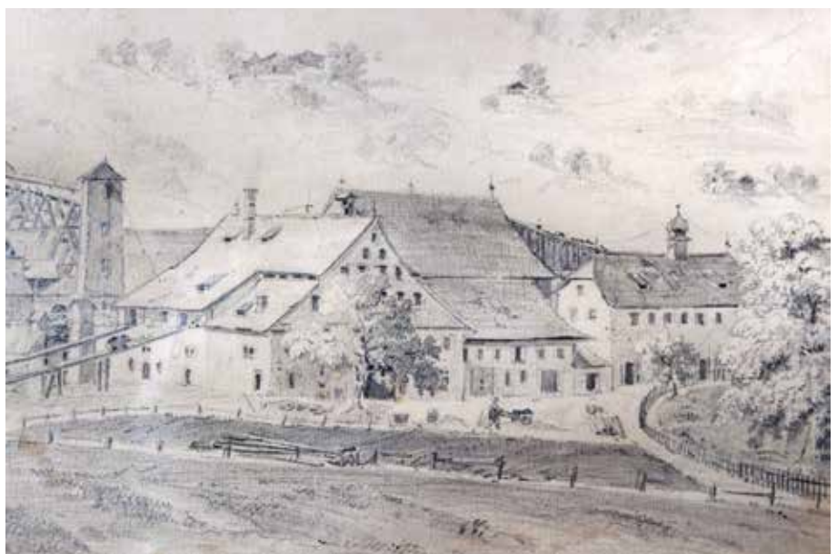
Hochofen in Plons um 1860. Der Hochofen wurde von Johann Georg Neher 1825/26 in Betrieb genommen und ohne Unterbruch bis 1868 beschickt. (Zeichnung von Emil Neher-Fischer, Privatbesitz).
